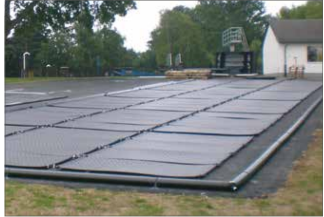
Montage auf ebener Freifläche
