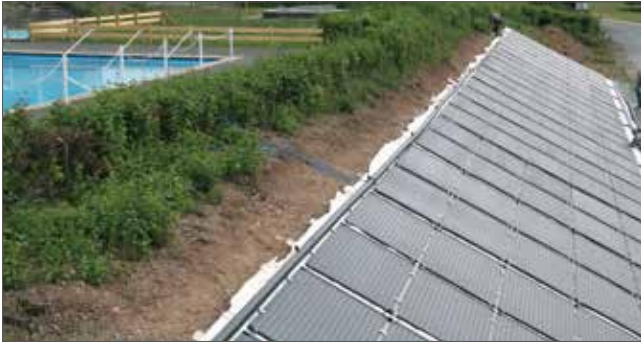
Freiflächenmontage Freibad Niedereisenhausen
