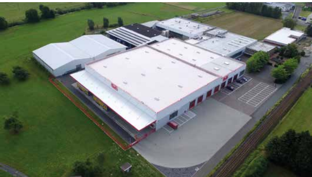
Abbildung 1 + 2: Neubau Logistikhalle, Roth Werke, Buchenau Roth Plastic Technology, Wolfgruben
